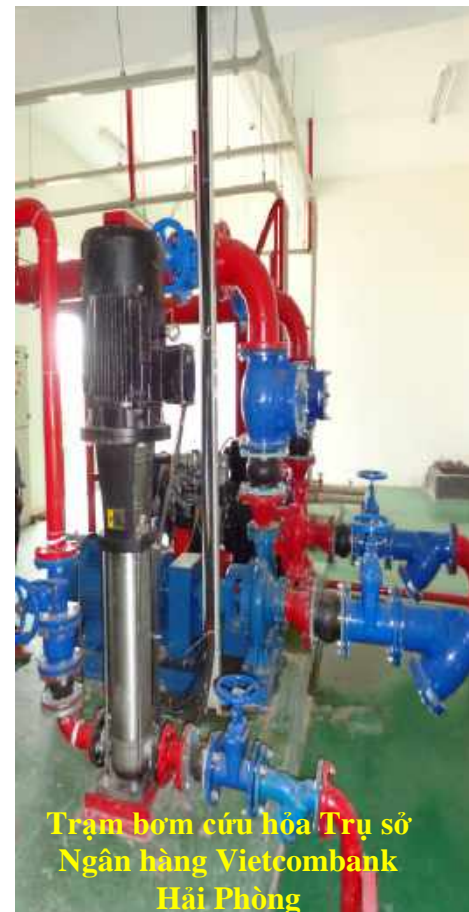
HT trạm bơm chữa cháy tự động Sprinler – Ngân hàng Vietcombank Hưng Yên
